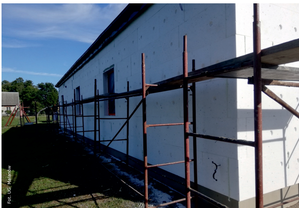
Świetlica w trakcie remontu
